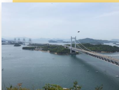
岡山県と香川県をつなぐ瀬戸大橋
